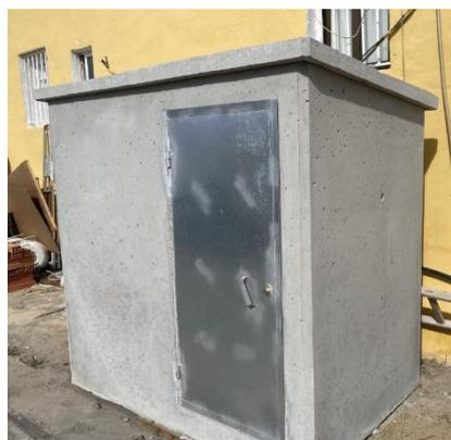
*Caseta prefabricada de hormigón.*
